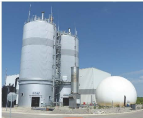
Metanizacja odpadów komunalnych – biogaz/e. elektryczna oraz kompost
